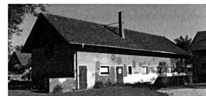
Eines der Nebengebäude, dessen Erhalt in den Sanierungskosten nicht enthalten ist
